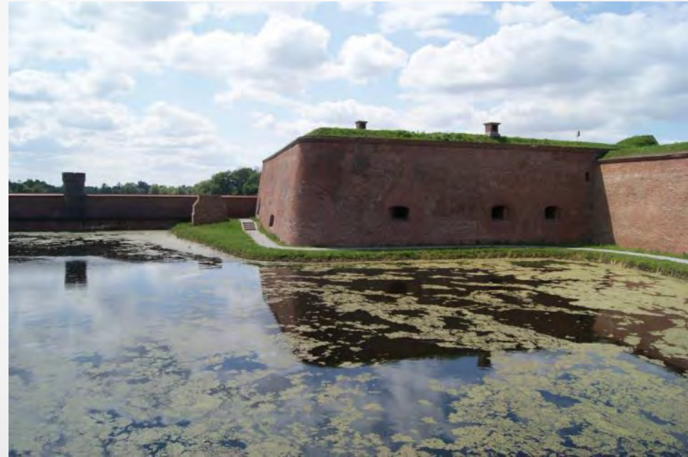
Restaurierte Festungsanlagen Odrestaurowane obiekty twierdzy
